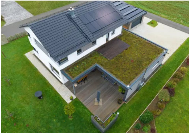
Gründach privates Einfamilienhaus in Süddeutschland
