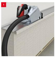
Aestuver® Brandschutzplatten werden mit schienengeführter Handkreissäge zugeschnitten
