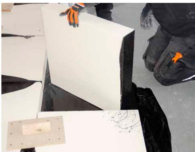
**Wärmedämmung BauderPIR KOMPAKT eingießen**
