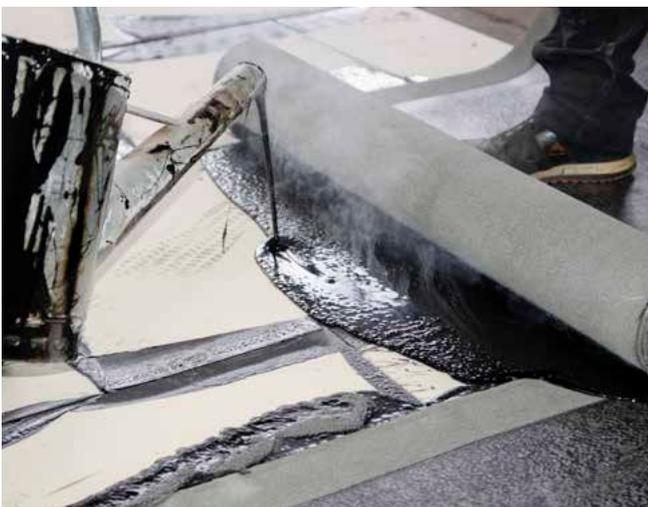
Erste Abdichtungslage BauderKOMPAKT ULK eingießen
