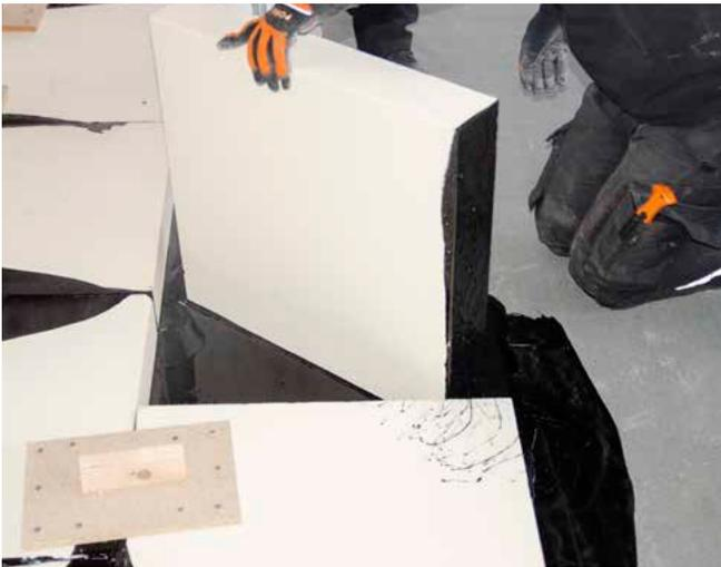
Wärmedämmung BauderPIR KOMPACT eingießen
