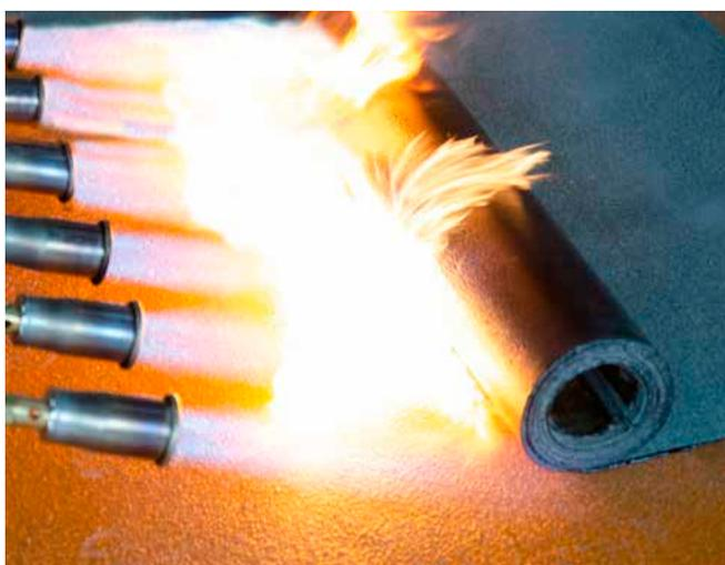
Dampfsperre BauderFLEX DNA aufschweißen
