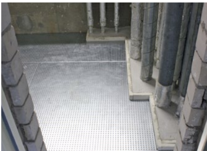
Konstruktion 420.51 Beispiel: begehbar mit Rohrabschottung
