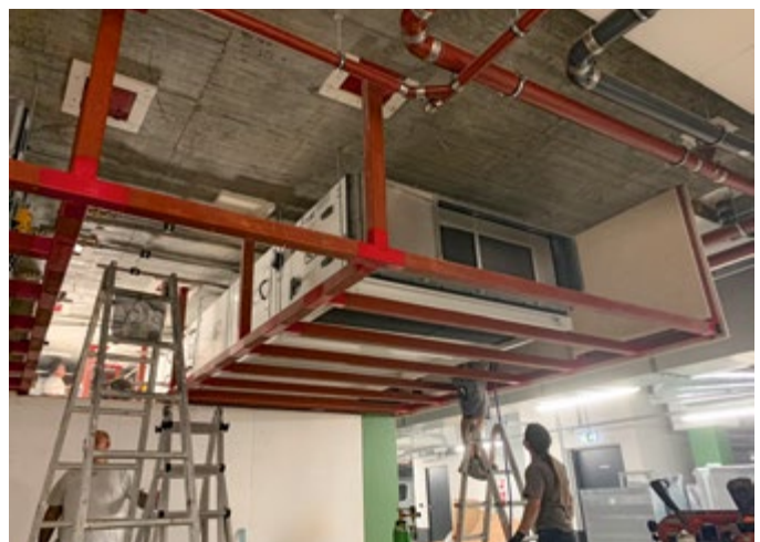
Konstruktion 420.51 Beispiel: als eigener Brandabschnitt für Lüftungsgeräte
