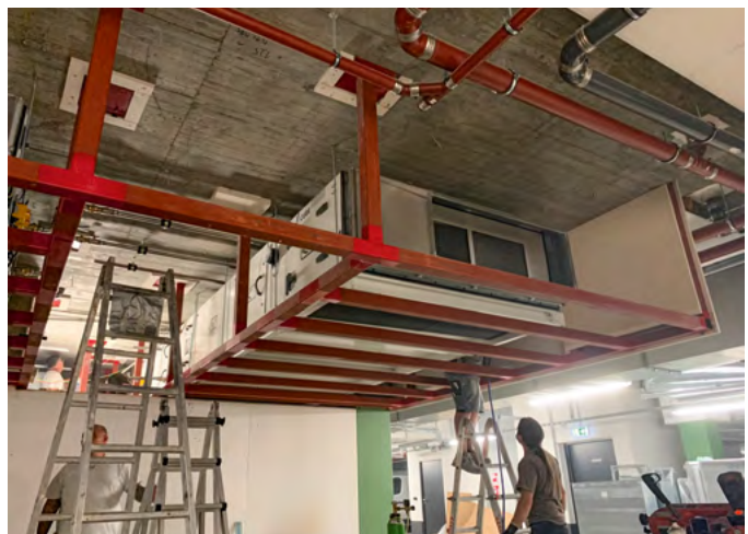
Konstruktion 420.51 Beispiel: als eigener Brandabschnitt für Lüftungsgeräte
