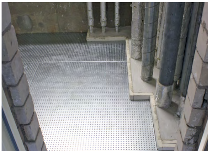
Konstruktion 420.51 Beispiel: begehrbar mit Rohrabschottung
