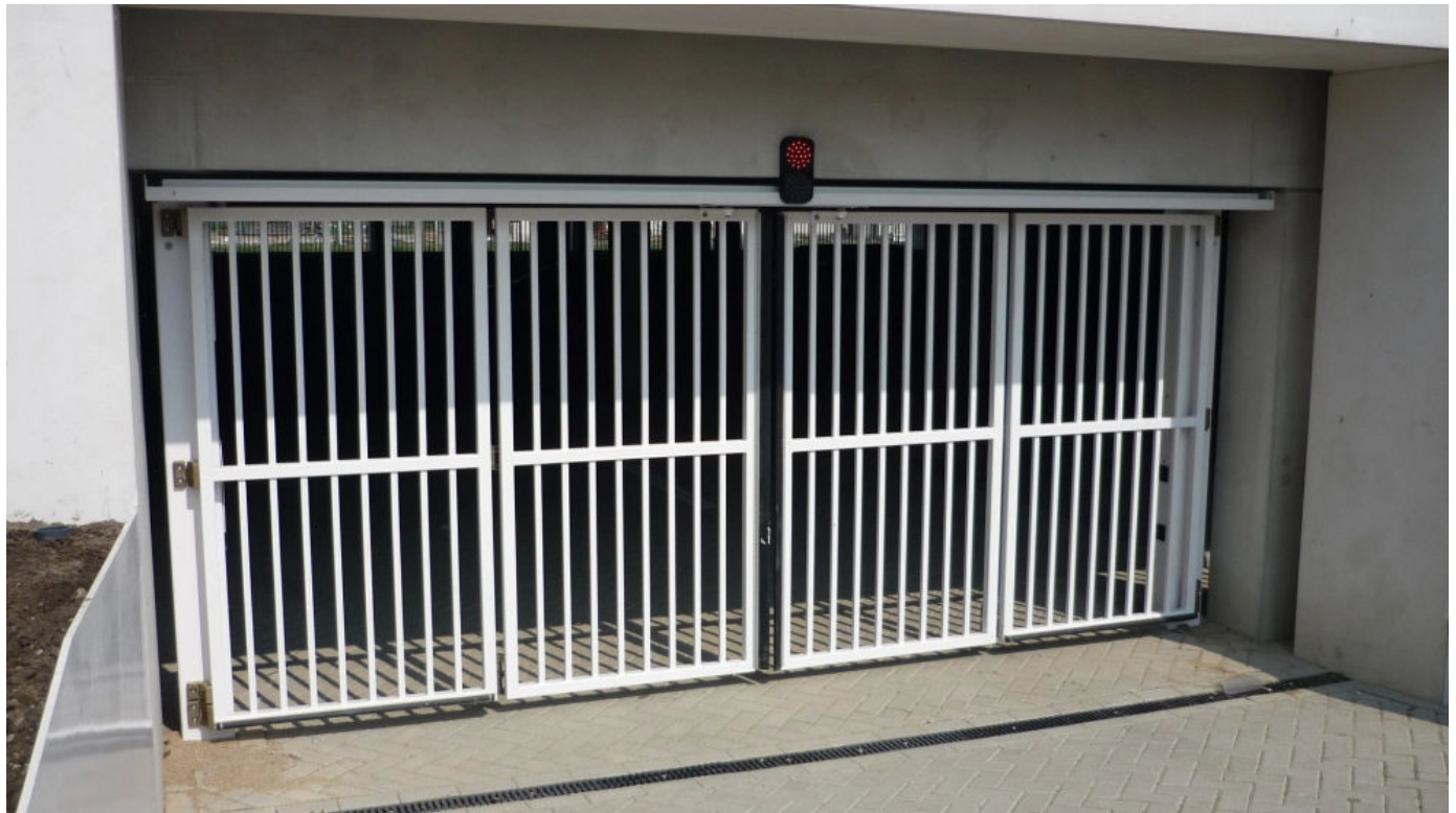
sGate mit Oberführung
