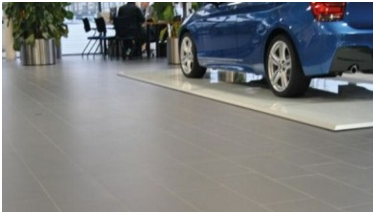
Injektionsflüssigkeit zum Rissverguss
