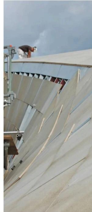
Das AMROC-Panel ist eine zementgebundene Spanplatte, die speziell für den Einsatz im Holzbau entwickelt wurde.
