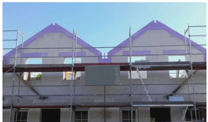
Wärmebrückendämmung - Giebelschalung
