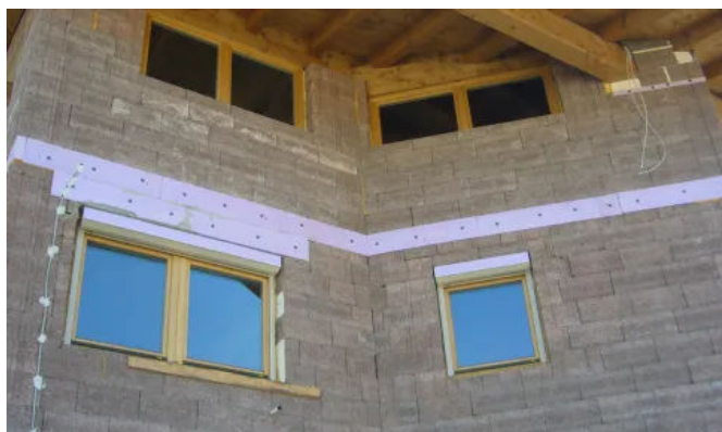
Wärmebrückendämmung - Deckenrandschalung
