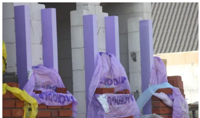
Wärmebrückendämmung - Mauerrandstreifen
