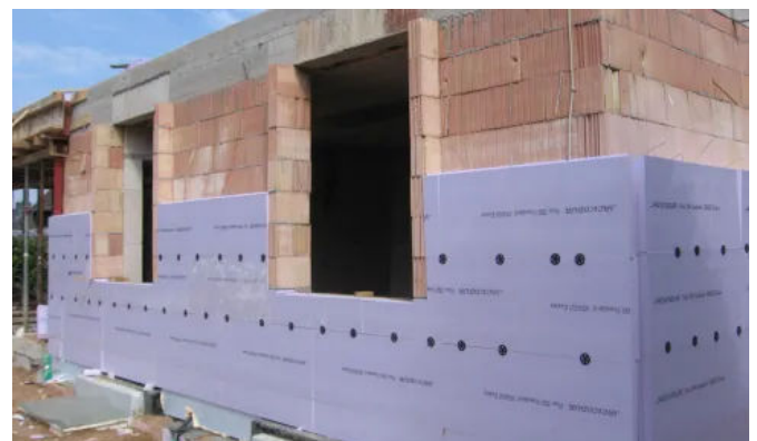
JACKODUR® Wärmedämmung - Beispielanwendung: Kerndämmung
