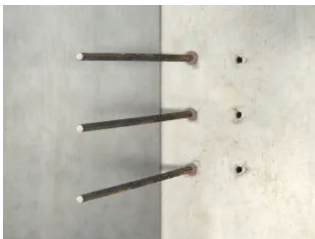
Einsatzbeispiel für nachträgliche Bewehrungsanschlüsse
