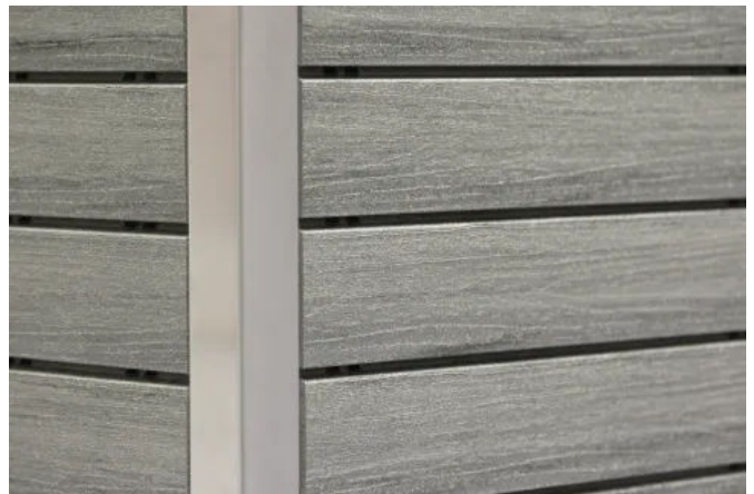
Die lichteichten Profile schützen sicher vor Schlagregen und Beschädigungen. Bild: NaturinForm
