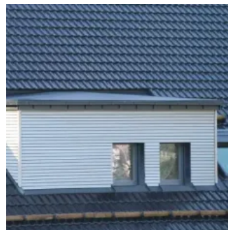
Abdichtung von Gauben
