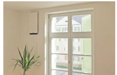
Während der Sanierung wurde das freeAir-Lüftungssystem installiert, wobei die Außenhauben und Innenabdeckungen der Geräte behutsam an den denkmalgeschützten Charakter des Wohnkomplexes angepasst wurden.
