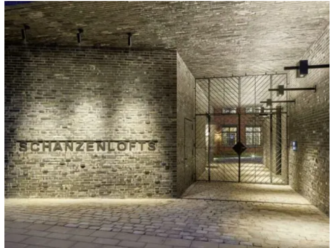
Schanzenlofts – Hamburg, Architekt: Giorgio Gullotta, Wittmunder Klinker 198.20 (© Jochen Stüber Fotografie)
