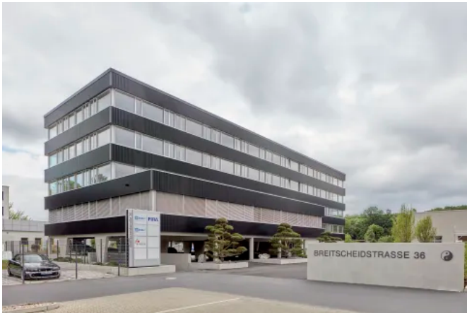
Bürogebäude FiraBau, Dresden ©Lukas Huneke
