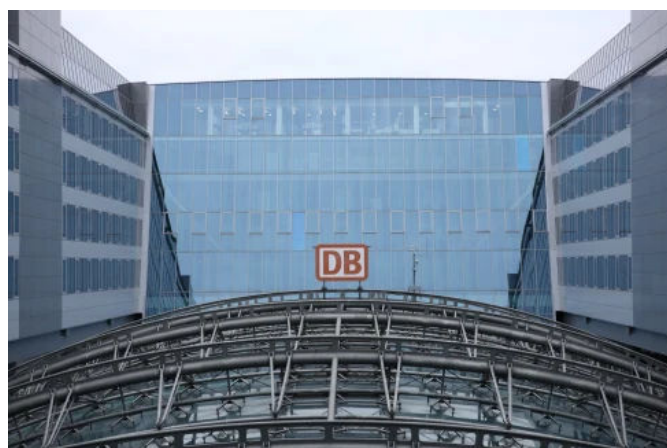
Projekt: The Squire, Frankfurt a. Main - WICTEC 50FP Brandschutzfassade (©Conné van d'Grachten)
