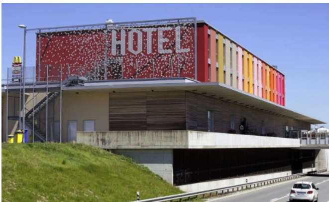
Vorgehängte Webnet-Fassade, Estavayer-le-Lac (CH)
