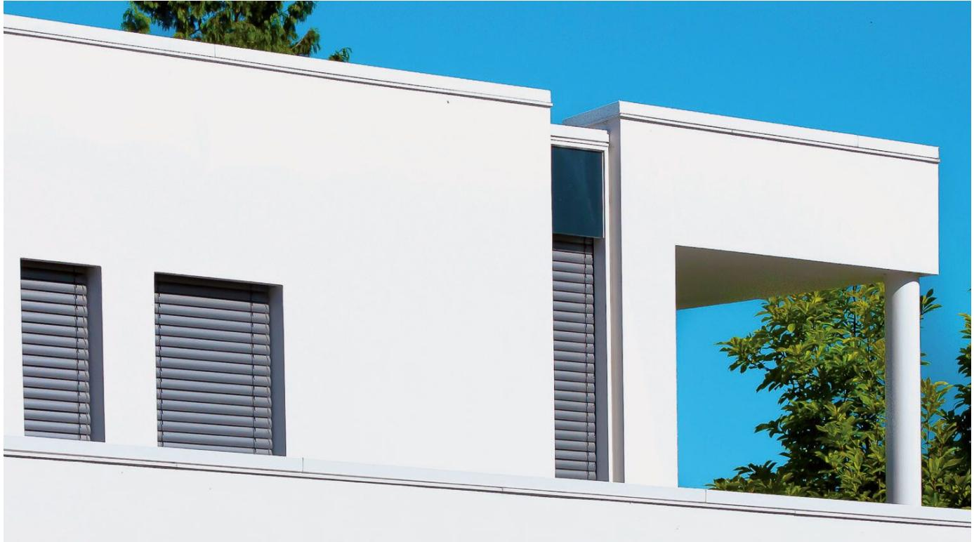
WDVS mit Hochleistungs-Dämmplatten aus Resol-Hartschaum und dickschichtigem Putzaufbau.
