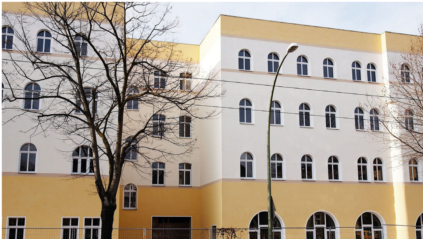
WDVS mit EPS-Dämmplatte und Putzaufbau
