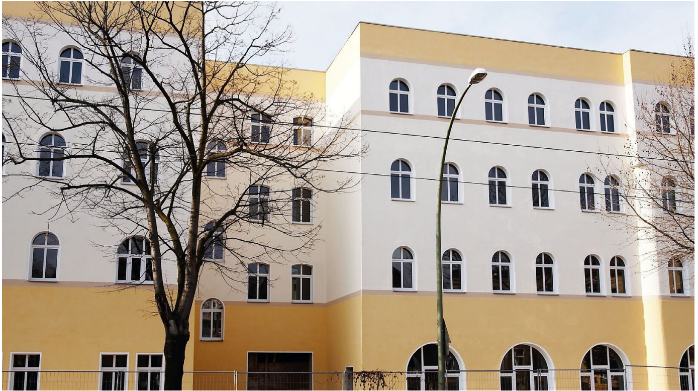
WDVS mit EPS-Dämmplatte und Putzaufbau
