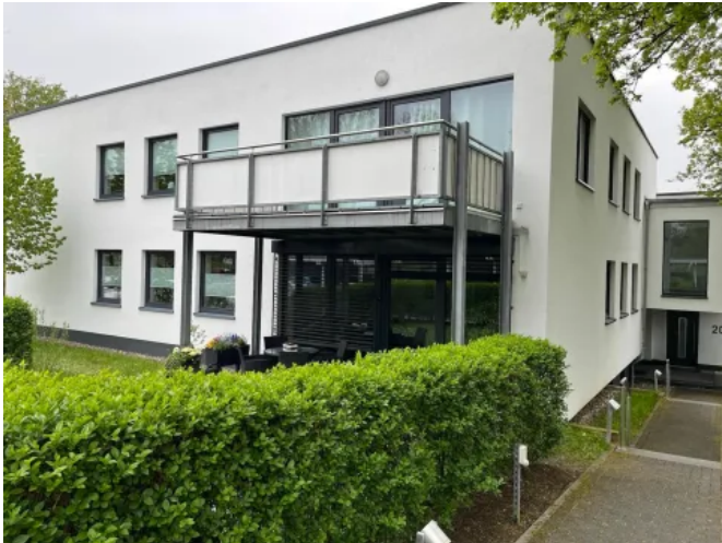
Der wasserdichte Balkonbelag ist gleichzeitig eine Überdachung für die darunter liegende Terrasse.
