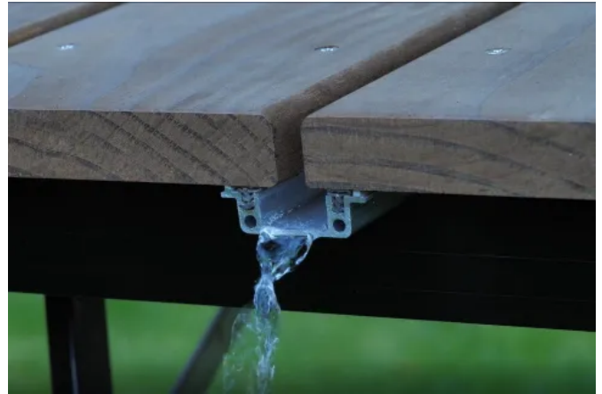
Montage mit sichtbaren Verschraubungen. Die U2020-Schiene leitet das Wasser gezielt ab.
