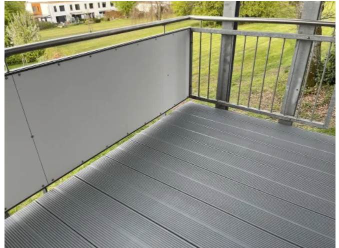
Die ebene Bodenfläche ohne sichtbare Verschraubungen wird durch die wasserleitenden Profile gleichmäßig entwässert.
