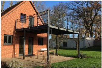
Terrassenüberdachung und Balkonboden in einer Funktion.
