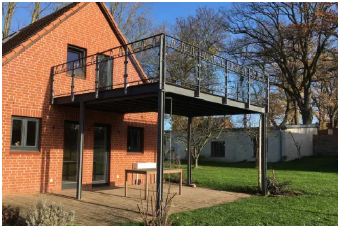
Terrassenüberdachung und Balkonboden in einer Funktion.
