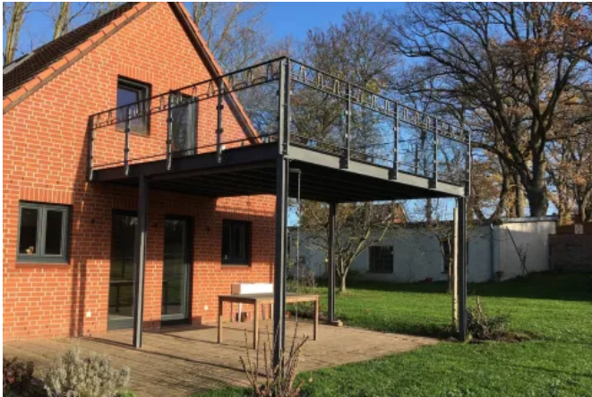
Terrassenüberdachung und Balkonboden in einer Funktion.
