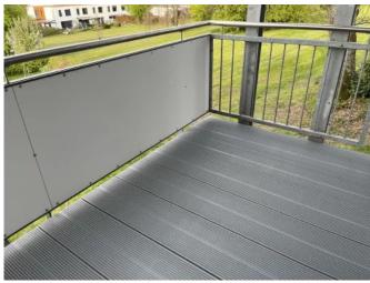
Die ebene Bodenfläche ohne sichtbare Verschraubungen wird durch die wasserableitenden Profile gleichmäßig entwässert.
