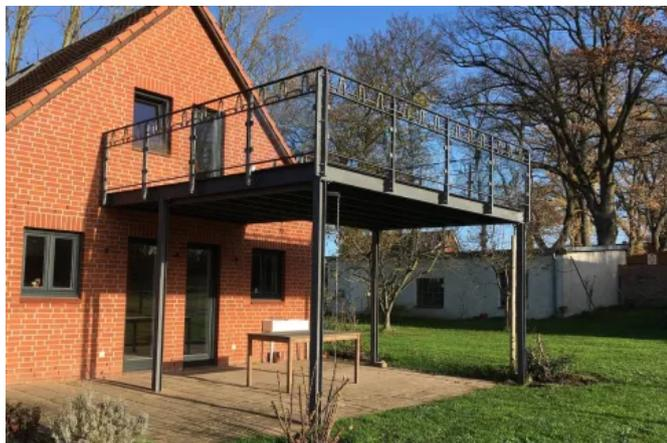
Terrassenüberdachung und Balkonboden in einer Funktion.
