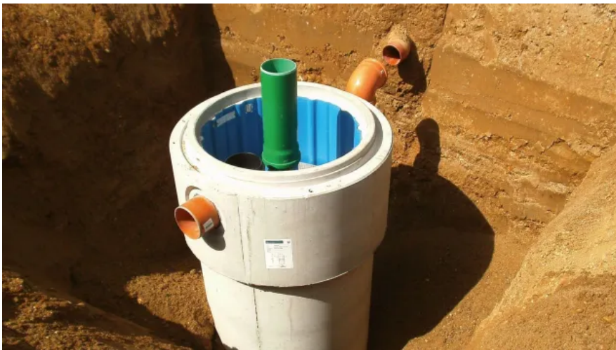
BIRCOhydropoint® - semizentrale Regenwasserbehandlung
