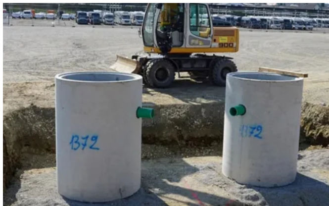
Einbau BIRCOhydroshark BV Hochdorf
