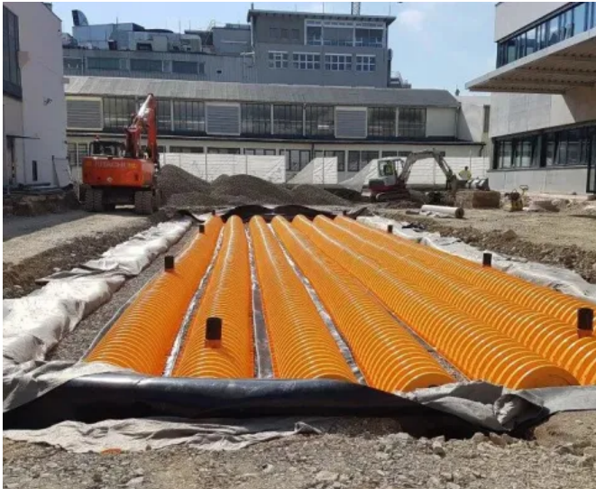
Retentionssystem mit gedrosseltem Ablauf
