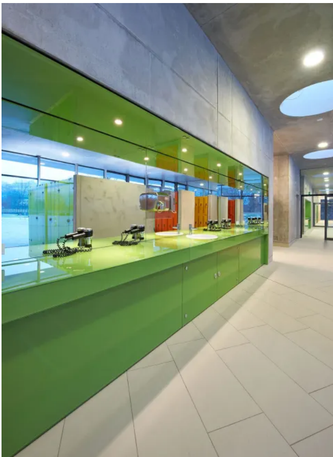
Fönplatz mit Unterschrank komplett aus Glas in einer Nische eingebaut
