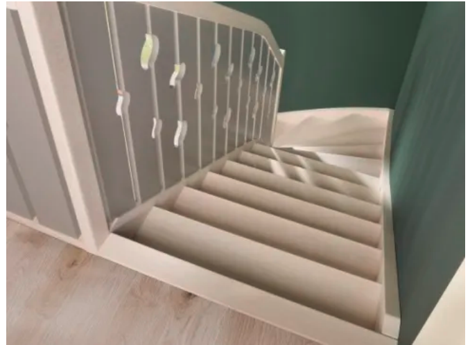
723e, Wangentreppe Aura, grau lackierte Holzgeländerfüllung
