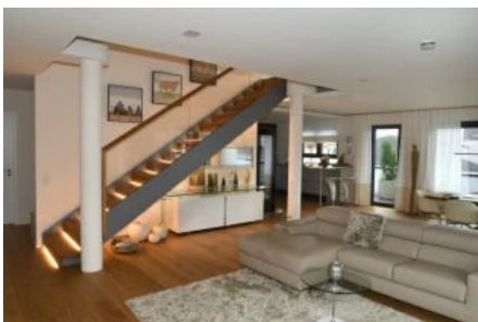
Wangentreppe mit integrierter Beleuchtung
