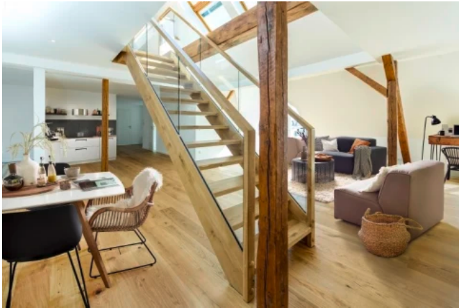
Wangentreppe mit Glasgeländer
