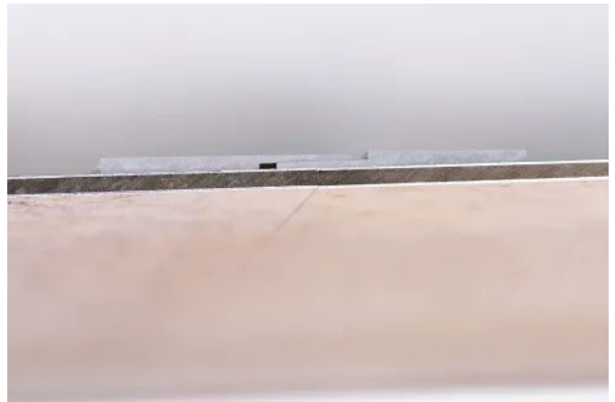
Plattenstoßprofil geschlossen
