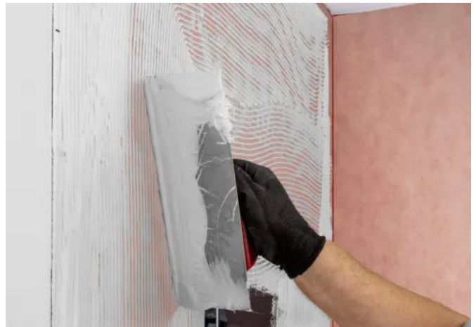
Vollflächige Verklebung mit 1-Komponenten Spezialkleber
