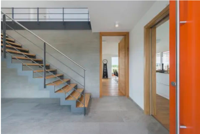
Flachstahlwangentreppe
