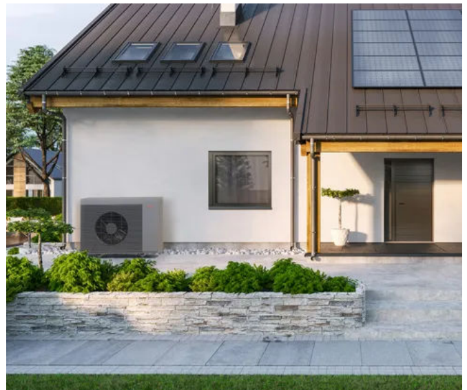
e Installation der Wärmepumpe in einem Vorgarten ist eine übliche Aufstellvariante. Geringe Abstände zur Hauswand erhöhen den Schallpegel. (© Wirestock Creators/Shutterstock)
