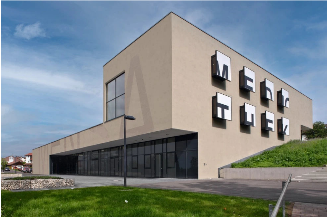
Mensa und Mediothek Schulzentrum Längenfeld, Balingen, DE, Quelle: Sto SE & Co. KGaA, Foto: Martin Duckek, Ulm, DE
