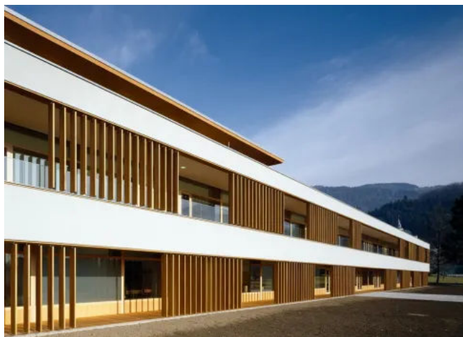
Landeskrankenhaus, Wolfsberg, AT, Quelle: Sto SE & Co. KGaA, Foto: Bruno Klomfar, Wien, AT
