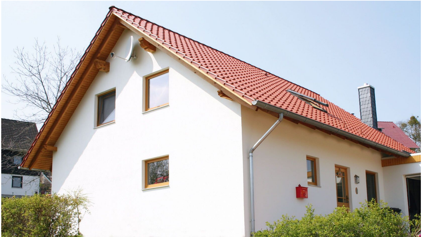
WDVS mit Holzweichfaser-Dämmplatten und ausgesuchten Oberputzen
