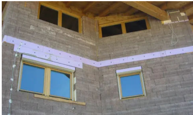
Wärmebrückendämmung - Deckenrandschalung
