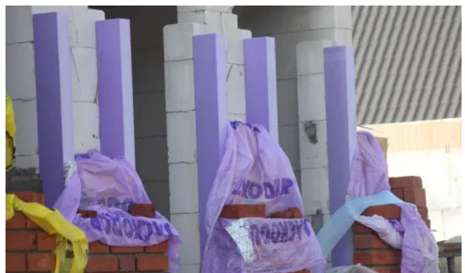
Wärmebrückendämmung - Mauerrandstreifen
