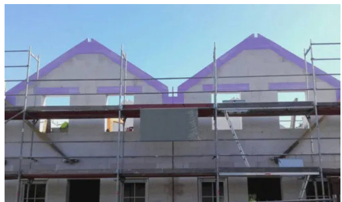
Wärmebrückendämmung - Giebelschalung
