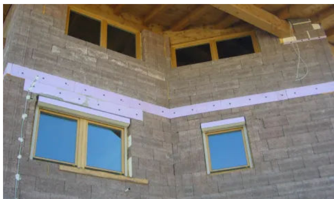
Wärmebrückendämmung - Deckenrandschalung
