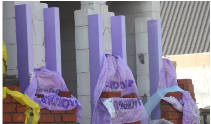
Wärmebrückendämmung - Mauerrandstreifen
