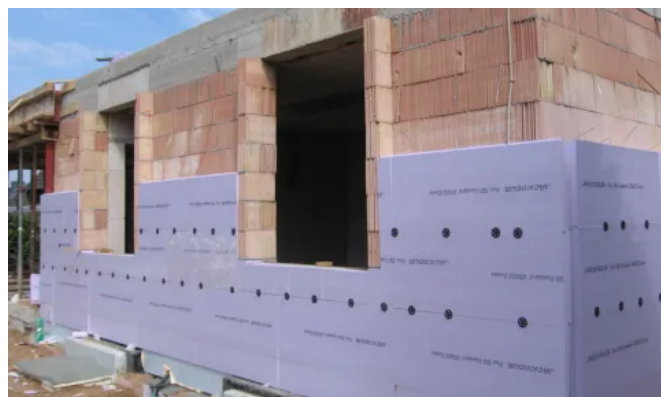
JACKODUR® Wärmedämmung - Beispielanwendung: Kerndämmung
