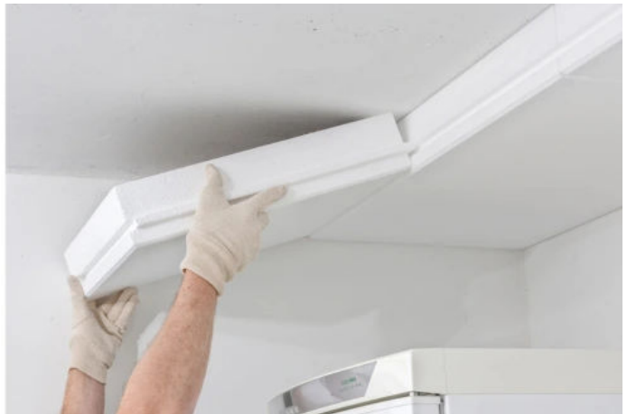
Kellerdecken-Dämmplatten mit Nut-Feder- oder Stufenfalzverbindung ermöglichen eine wärmebrückenarme Kellerdeckendämmung im Bestand.
