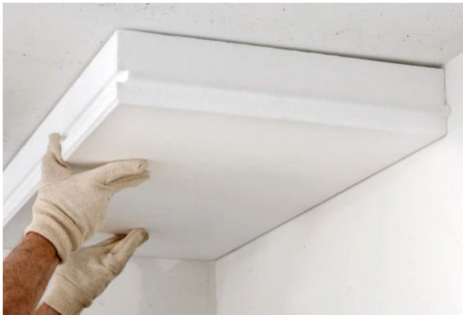
Kellerdecken-Dämmplatten mit Nut-Feder- oder Stufenfalzverbindung ermöglichen eine wärmebrückenarme Kellerdeckendämmung im Bestand.
