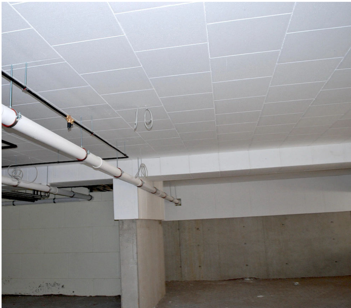
Gedämmte Tiefgaragendecke mit HIRSCH Porozell Deko-Dämmplatte 035 DI aus EPS für verbesserter Wärmeschutz und Wohnkomfort.
