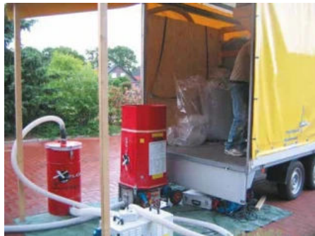
Zertifizierte Fachbetriebe verarbeiten das EPS-Granulat schnell, staubarm und ohne aufwändige Fassadensanierung.
