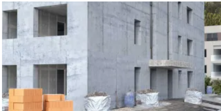
Beton-Rohbau
