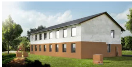
Während der Bauphase
