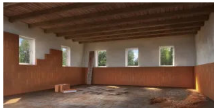
Während der Bauphase
