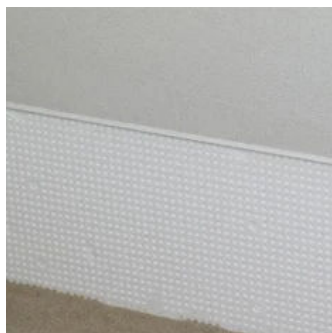
Schritt 6: Verklebung der Sockeldämmplatten inkl. WDVS Dichtband.
