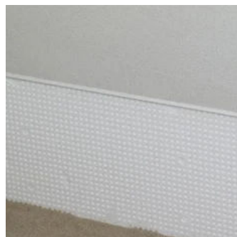
Schritt 6: Verklebung der Sockeldämmplatten inkl. WDVS Dichtband.
