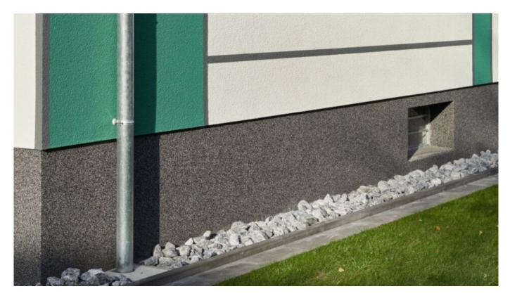
Hartschaum-Sockeldämmplatten verhindern eine Wärmebrücke an erdberührten Bauteilen der Außenwand. Das WDVS-Sockelabschlussprofil 3815 von Brillux ergänzt die Sockeldämmplatten und ermöglicht eine wärmebrückenfreie, schnelle Ausbildung von zurückspringenden Sockelflächen.
