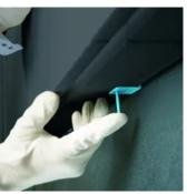
Schritt 2: Kleber auftragen, Qju Dämmplatten anstellen, fluchtgerecht ausrichten und unterseitig mit Fixierungsnägeln fixieren.
