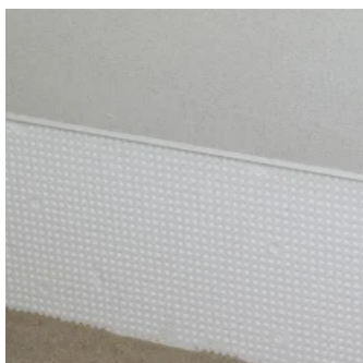
Schritt 6: Verklebung der Sockeldämmplatten inkl. WDVS Dichtband.
