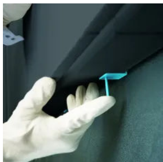
Schritt 2: Kleber auftragen, Qju Dämmplatten anstellen, fluchtgerecht ausrichten und unterseitig mit Fixierungsnägeln fixieren.
