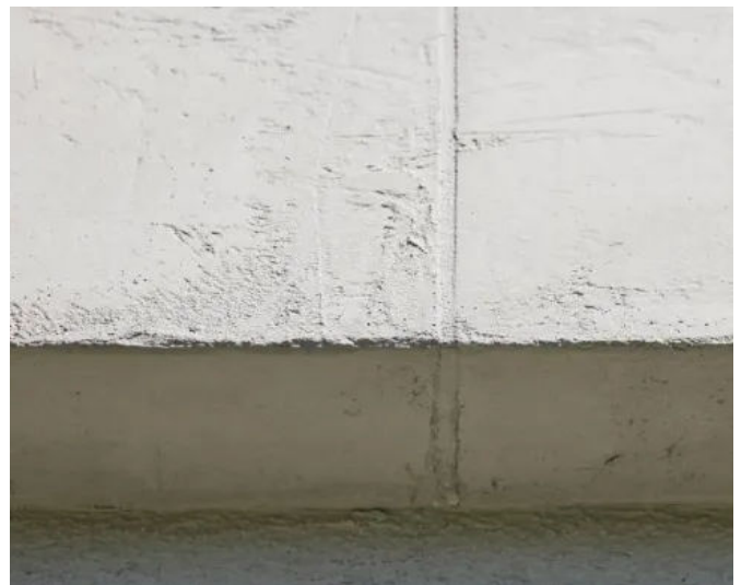
Ausführungstechnik Sichtbeton glatt
