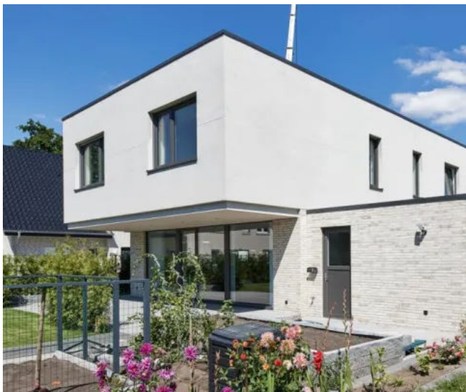
Ausführungstechnik Sichtbeton glatt
