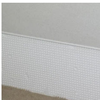
Schritt 6: Verklebung der Sockeldämmplatten inkl. WDVS Dichtband.
