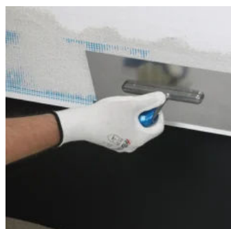
Schritt 5: Zuerst die Gewebefahne einarmieren und anschließend die Flächen.
