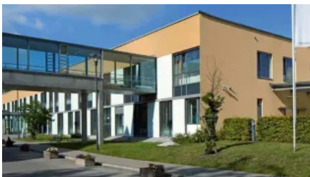
Asklepios Westklinikum Rissen, Hamburg, DE; Quelle: Sto SE & Co. KGaA, Foto: Christoph Gebler, Hamburg, DE
