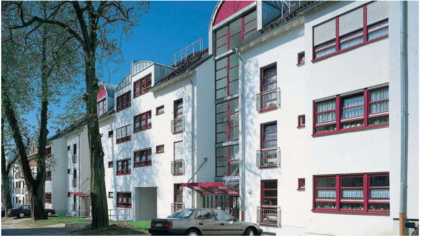
Wärmedämm-System mit mineralischem Dämmputz und mineralischen Edelputzen
