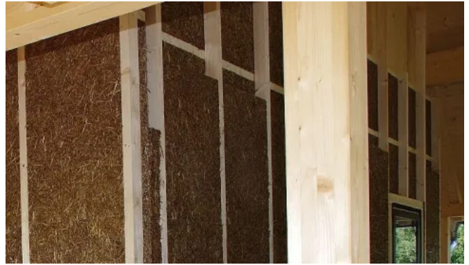
Fassadendämmung Neubau, Rußbach | Fläche ca. 250 m 2
