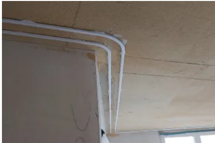
Profil HM-105 | zwei 1-läufige Profile mit Rundungen
