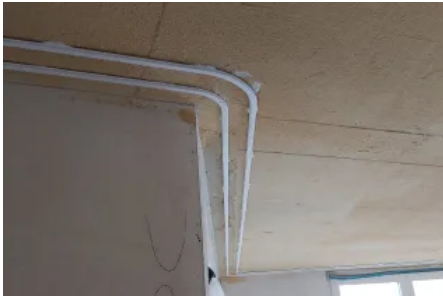
Profil HM-105 | zwei 1-läufige Profile mit Rundungen
