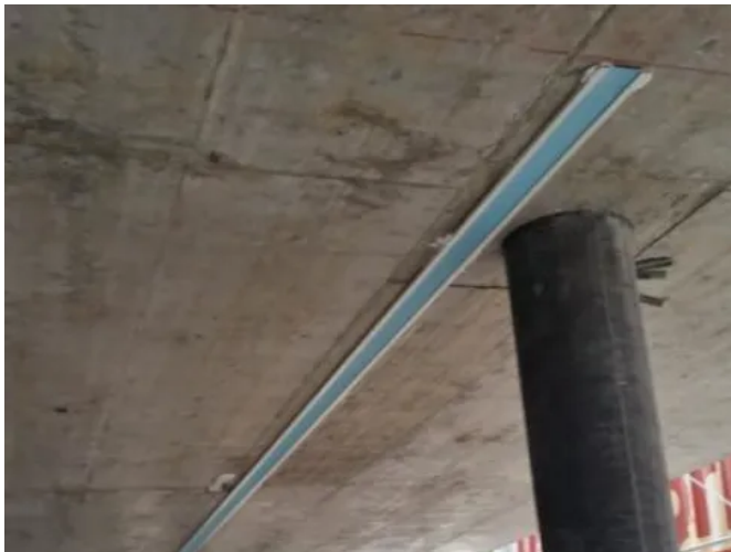
Unterputz-Profil HM-20105 | montiert an Betondecke
