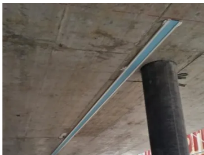
Unterputz-Profil HM-20105 | montiert an Betondecke
