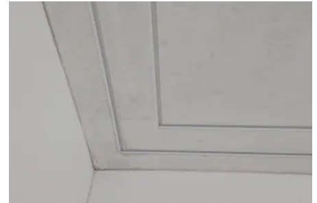
Profil HM-105 | zwei 1-läufige Profile nach dem Verspachteln
