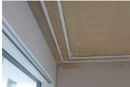
Profil HM-105 | zwei 1-läufige Profile mit Gehrungsschnitt
