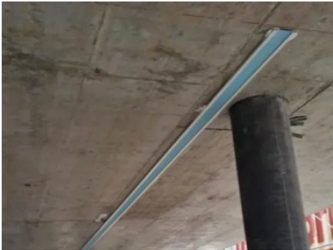
Unterputz-Profil HM-20105 | montiert an Betondecke
