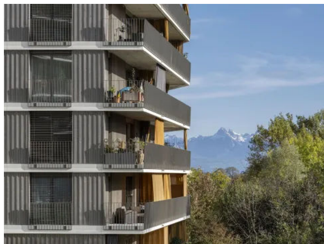
Profil HM-20150 für den Außenbereich | Ecoquartier in Nyon, Kanton Waadt
