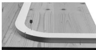
... Profil auf Montagebänder geklippt, mit Nägeln fixiert ...
