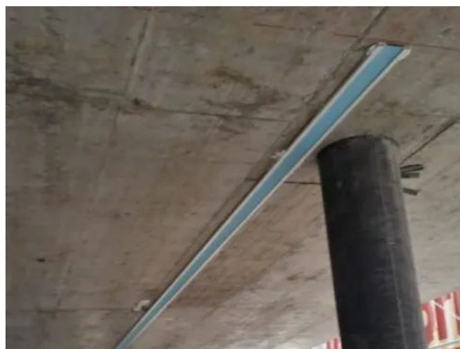
Unterputz-Profil HM-20105 | montiert an Betondecke
