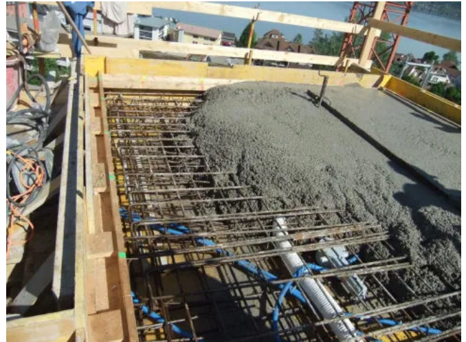
Betonieren der Stahlbetondecke
