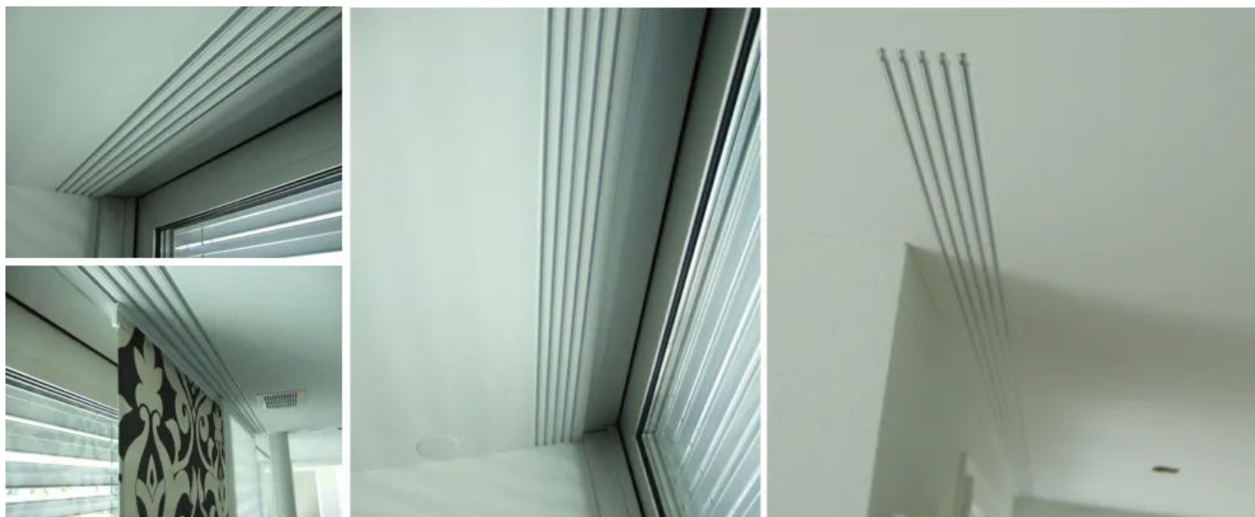
5-läufiges Profil HM-20625-GP5 | eingebaut in einem privaten Wohnraum
