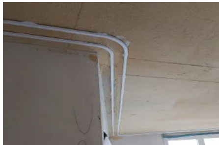
Profil HM-105 | zwei 1-läufige Profile mit Rundungen
