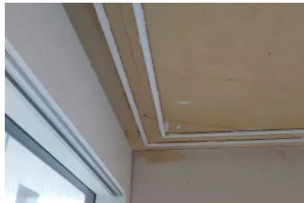
Profil HM-105 | zwei 1-läufige Profile mit Gehrungsschnitt
