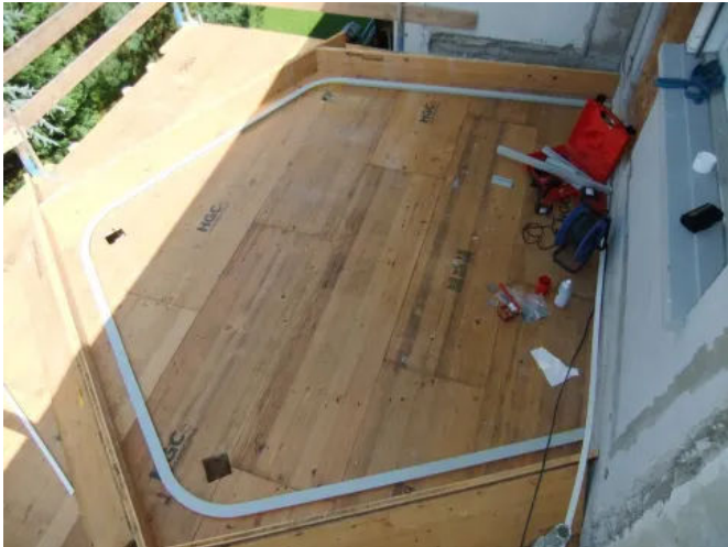
Exakte Positionierung des Profils auf der Schaltafel inkl. Rundungen
