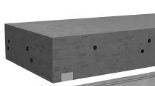
... nach dem Aushärten die Schalttafel entfernt ...
