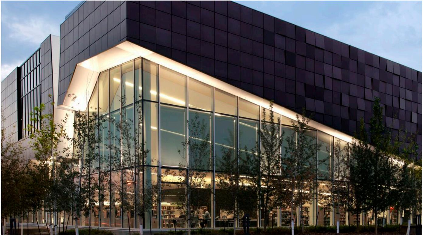
Das vielseitige Karrier-Fassadensystem ermöglicht wirtschaftliche Fassadenlösungen mit individuellem Design und ist eine Alternative zu herkömmlichen mehrteiligen vorgehängten Fassadenverkleidungen. Die Fassadenverkleidung - metallisch oder und nicht metallisch - wird direkt mittels einer System-Unterkonstruktion auf den Sandwichpaneelen angebracht. Das Gesamtsystem hat die DIBT-Zulassung und steht in verschiedenen Oberflächenvarianten zur Verfügung.
