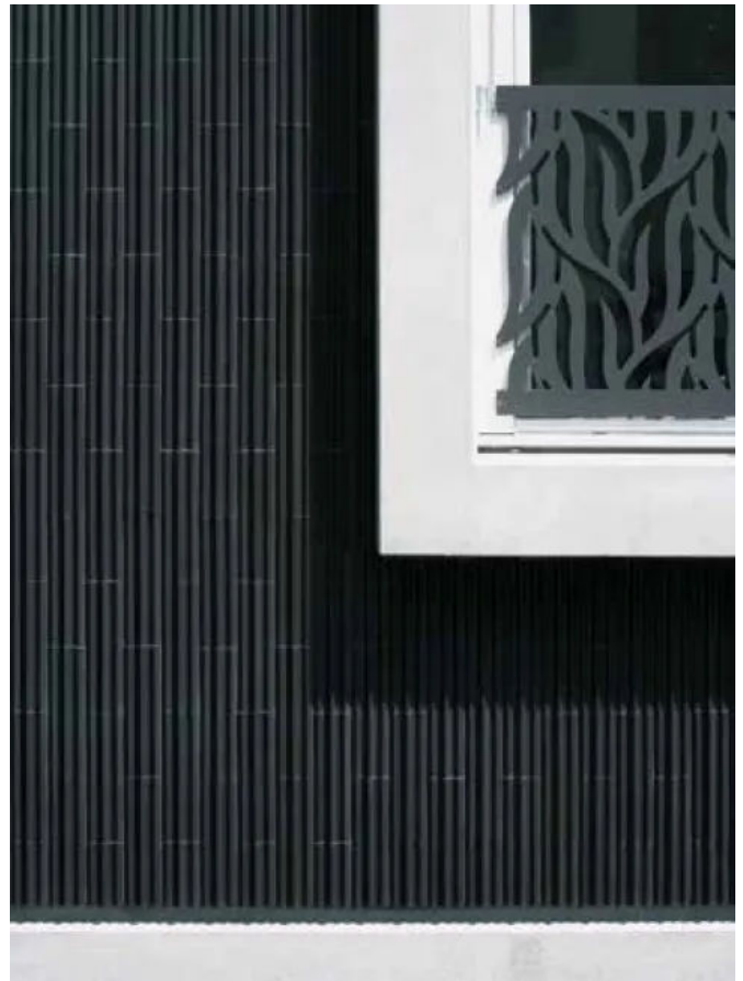
Materialübergang vom Sockel und Fenster zur Keramikfassade
