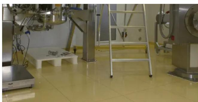
Lose verlegbare, großformatige Fliesen, 600 x 600 mm, Dicke 6 mm, Nutzschicht 2 mm, mit glatter Kante, thermische Verschweißung, für Reinräume
