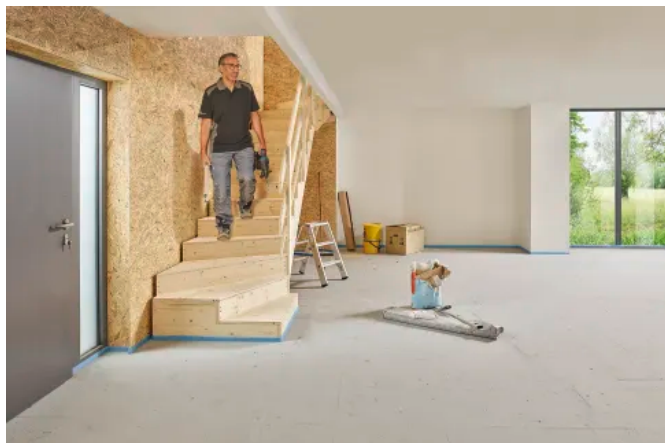
Bautreppe Vario während der Bauphase (© studio 3001)
