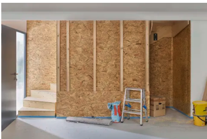
Bautreppe Vario während der Bauphase (© Treppenmeister GmbH)
