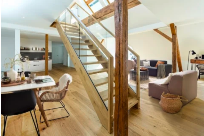
Wangentreppe mit Glasgeländer
