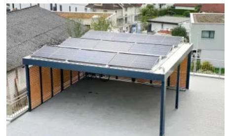
Carport mit Photovoltaik
