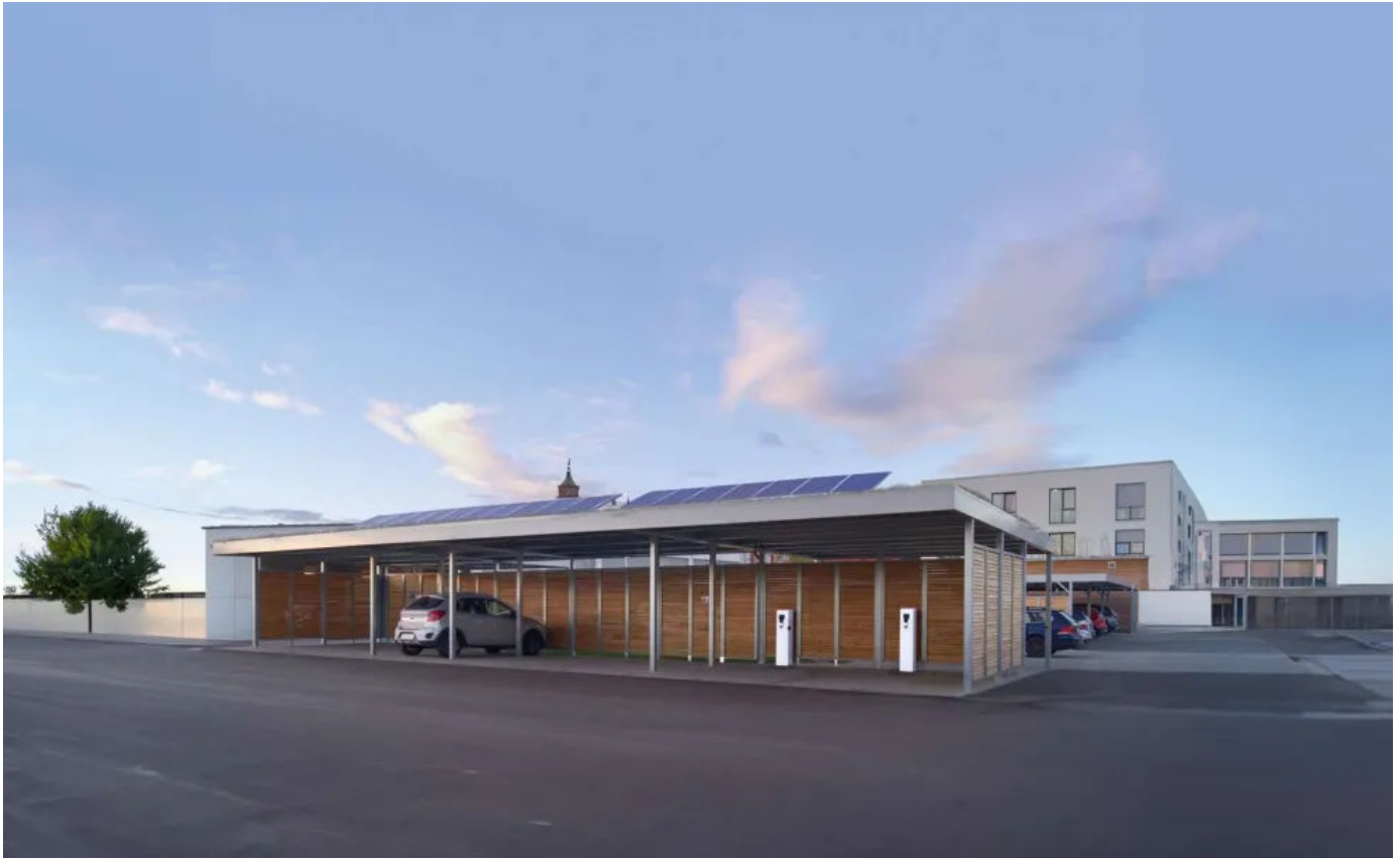
Reihencarport mit Sichtschutzelementen aus Holz und Wallboxen zum Laden von E-Autos
