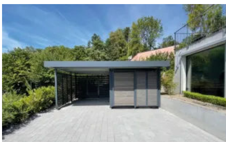
Einzelcarport mit Geräteraum
